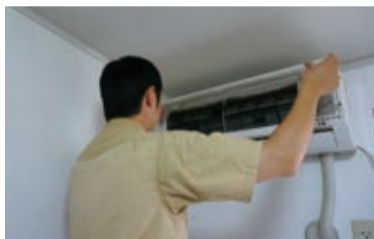
▲エアコン不具合点検
