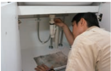
▲洗面排水詰まり
