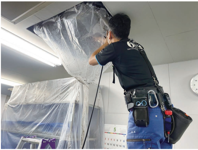
▲ 水垢やカビ等の汚れを徹底洗浄します。
